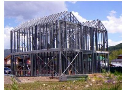
Figura 16. Estructura construida mediante steel frame
