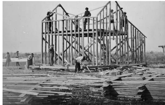
Figura 13. Construcción a base de listones de madera
