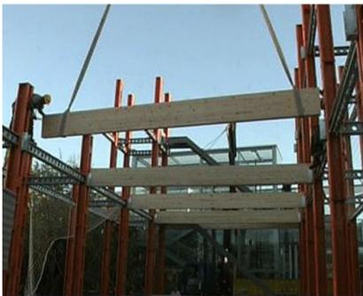
Figura 145. Colocación de vigas de madera
