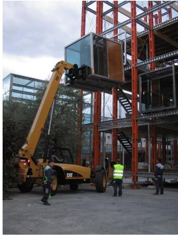
Figura 147. Elevación de los módulos 3D
