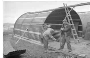
Figura 41. Montaje del aislamiento con paneles exteriores
