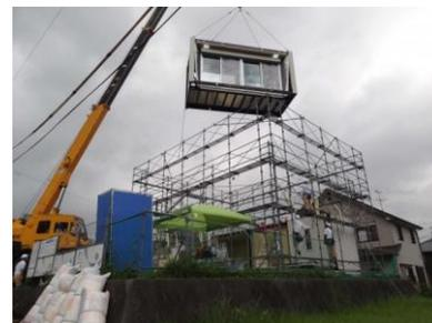
Figura 112. Colocación de módulos
