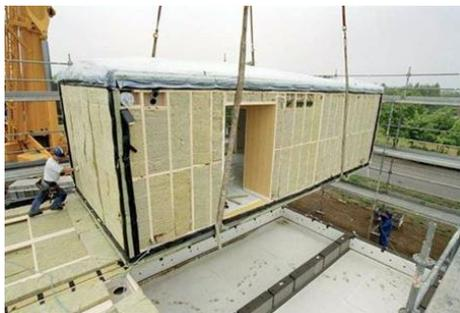
Figura 126. Colocación módulos 3D
