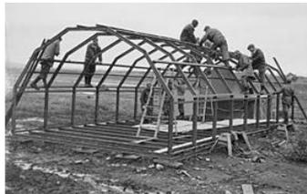
Figura 40. Montaje paneles interiores
