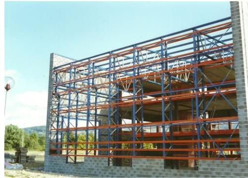
Figura 2. Construcción mediante un sistema estructural tipo estanterías
