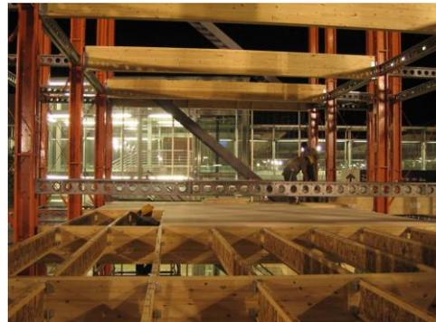
Figura 146. Composición del forjado.
