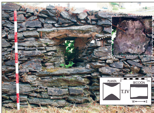
Figura 10. Imagen de una tronera con detalles de su morfología y restos de mortero (cal y arena) que delatan su empleo como revoco en el paramento murario.
