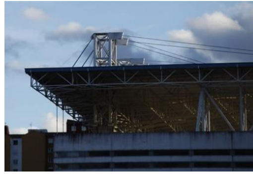
Figura 8.6.- (1) Estadio Carlos Tartiere desde un plano picado y (2) torres tirantes de las cubiertas laterales.
