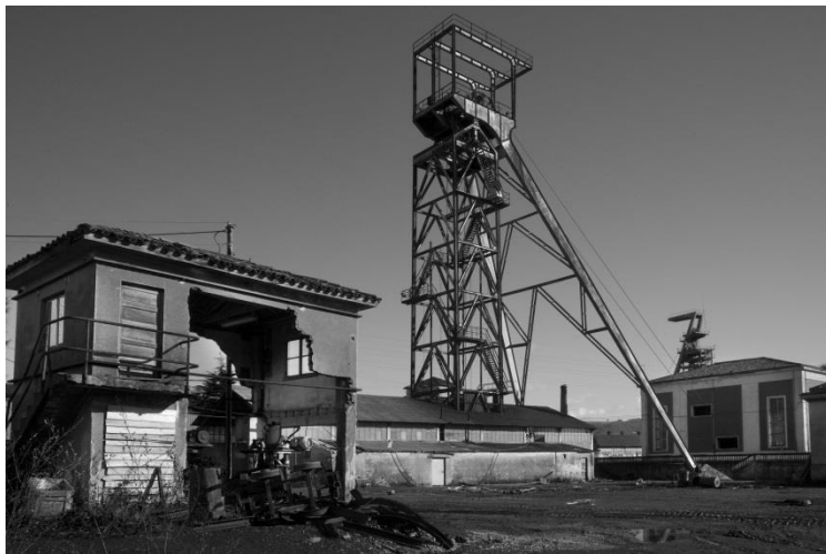
Figura 22. Tras más de 50 años de actividad, en diciembre de 2007 tuvo lugar el cese de la actividad de Mina La Camocha. En la imagen, castillete del pozo n° 3 e instalaciones aledañas en los últimos días de actividad de las instalaciones industriales. Fotografía de Sergio Vega Vázquez.
