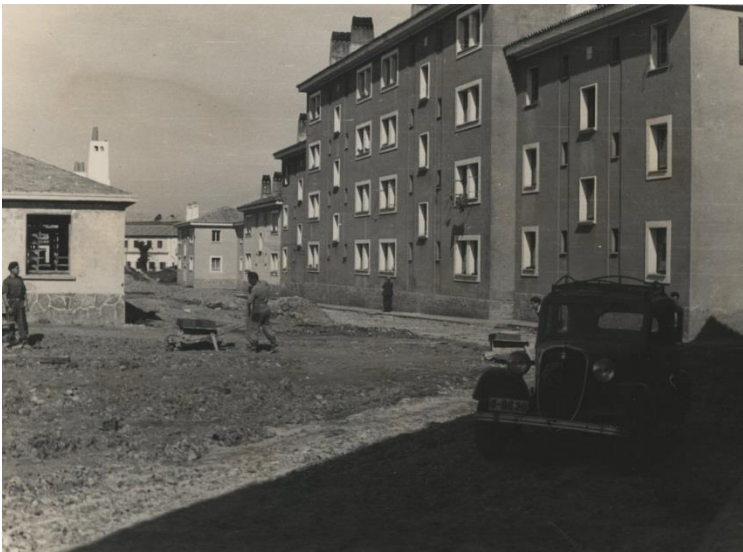
Figura 20. Obras de construcción del poblado de Les Cases a principios de la década de 1950. Fotografía procedente del Archivo del Museo del Ferrocarril de Asturias, colección Carlos Rocés Felgueroso.
