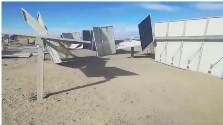
*Figura 2. Paneles solares volados por la fuerza del viento en un parque solar en Argentina, 2018 [2]*
