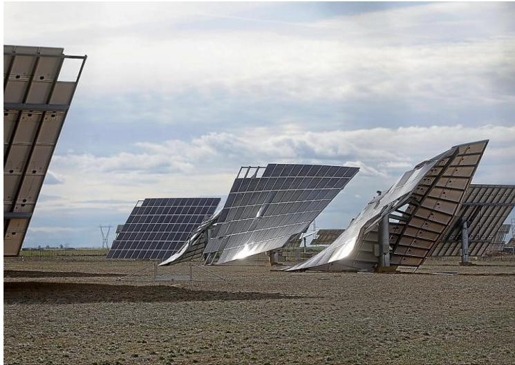
*Figura 1. Paneles solares doblados por la fuerza del viento en la finca de La Mudarra, Valladolid-2018 [1]*
