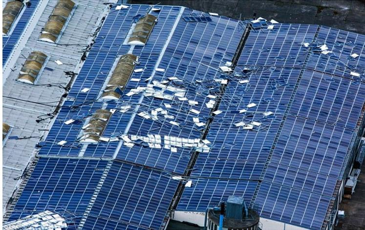
Figura 3. Cubierta solar destruida por un tornado en Alemania, 2015 [3]
