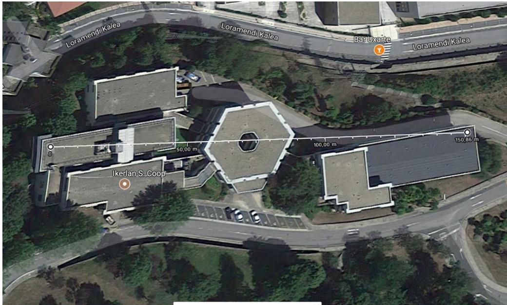
Figura 44 Instalaciones de Ikerlan en Arrasate.
