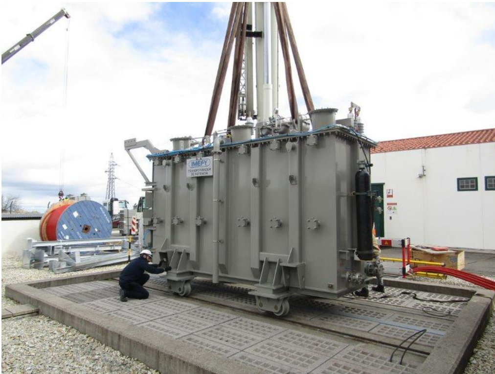
Figura 7.8 Descarga del transformador de potencia sobre la bancada
