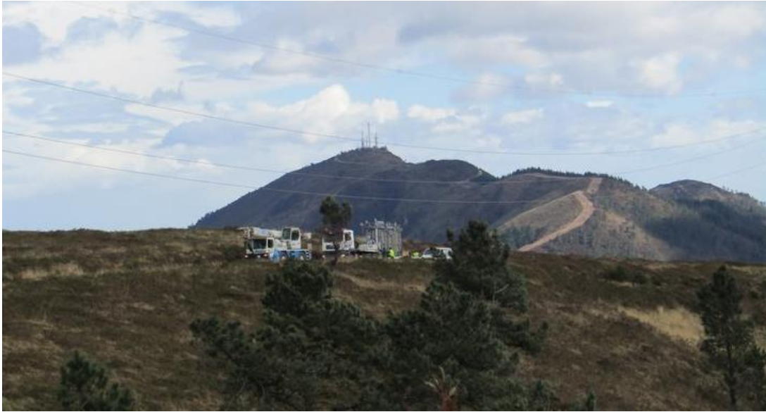
Figura 7.5 Transporte del transformador de potencia
