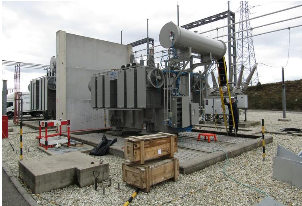
Figura 7.9 Montaje final del transformador de potencia sobre la bancada
