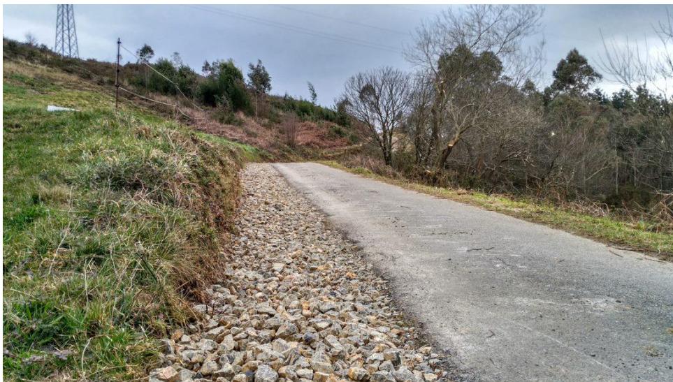
Figura 7.2 Vía de acceso reforzada
