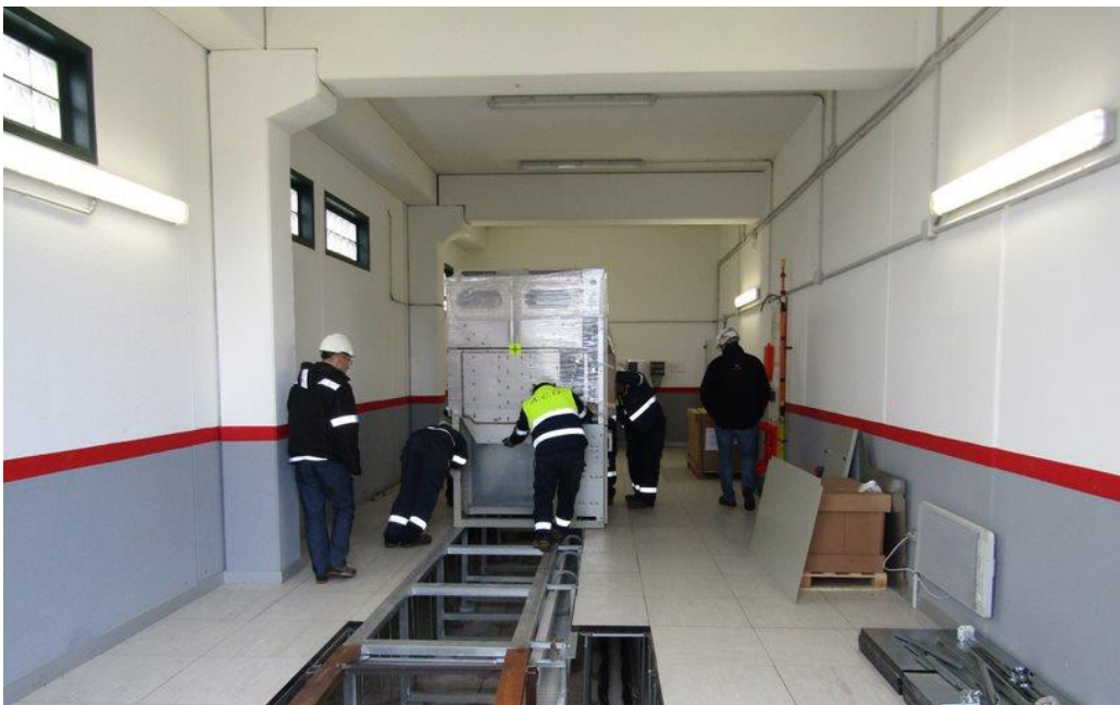
Figura 7.12 Instalación de las cabinas de 20 kV
