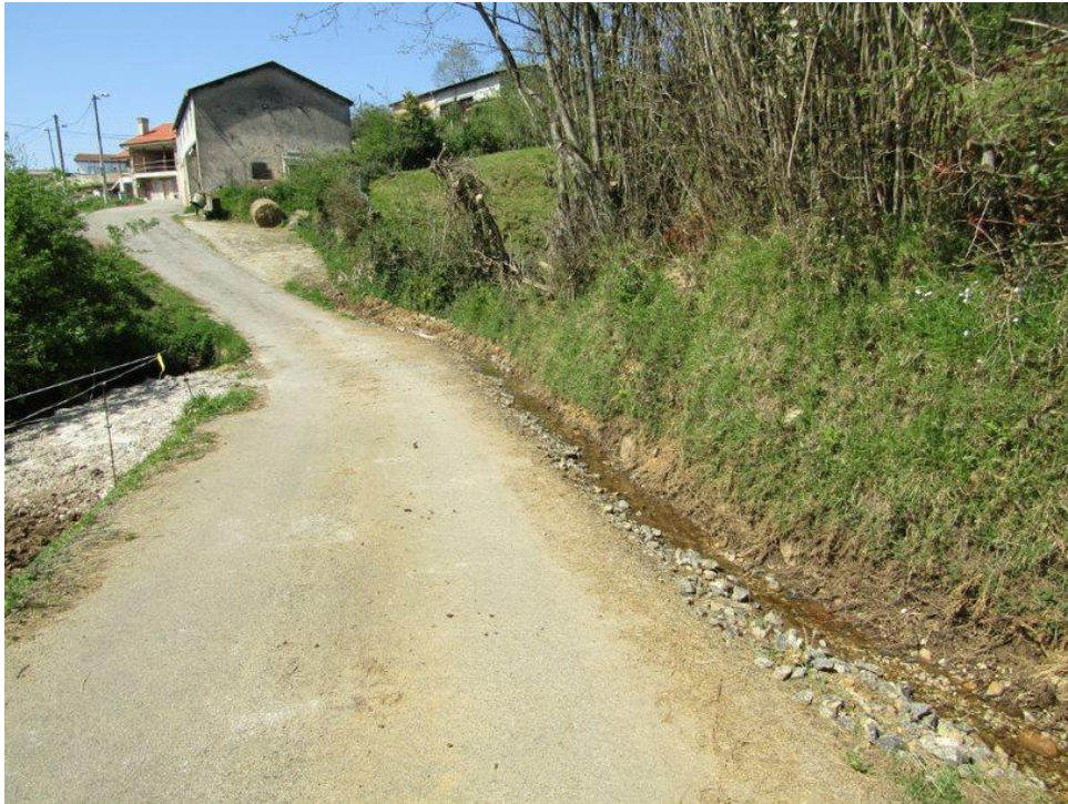
Figura 7.1 Vía de acceso con ancho insuficiente
