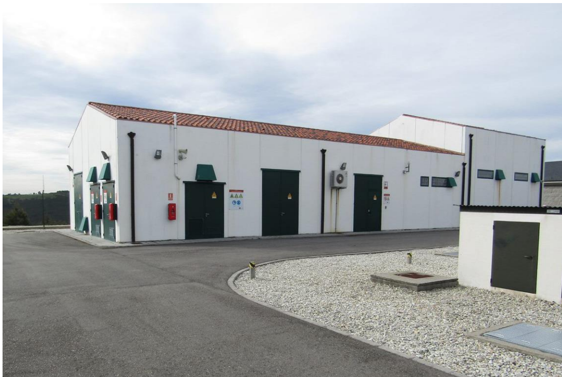
Figura 4.3 Exteriores de la subestación eléctrica de Romió
