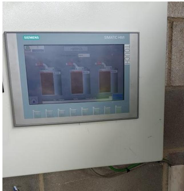
Imagen 12. Sistema de control por PLC. Fuente: Autor
