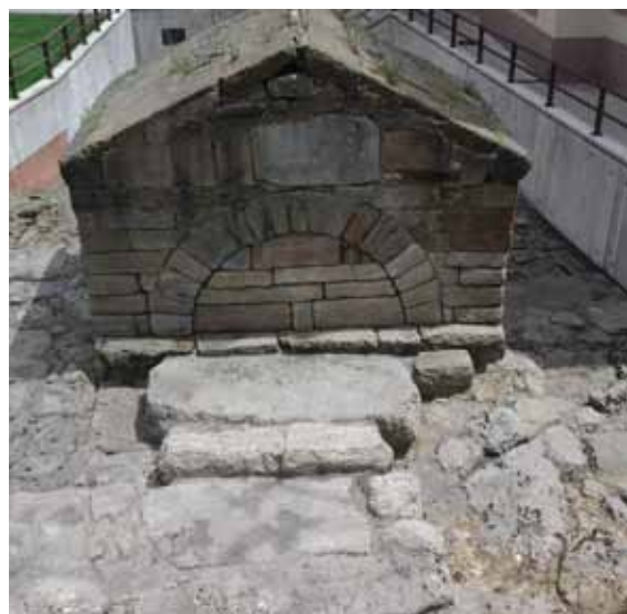
Fig. 14. Fuente de la Foncalada, detalle del frontón trasero, restaurado con piedra diferente y sillares a tizón en época altomedieval (J. A. Gutiérrez).
