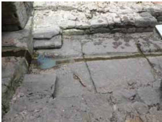
Fig. 10. Fuente de la Foncalada, cazoleta y canal tallados en las losas basales (J. A. Gutiérrez).
