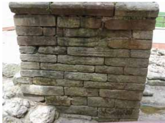
Fig. 13. Fuente de la Foncalada, pared lateral sur del edículo, donde se aprecia el empleo de material diferente en las hiladas superiores (J. A. Gutiérrez).
