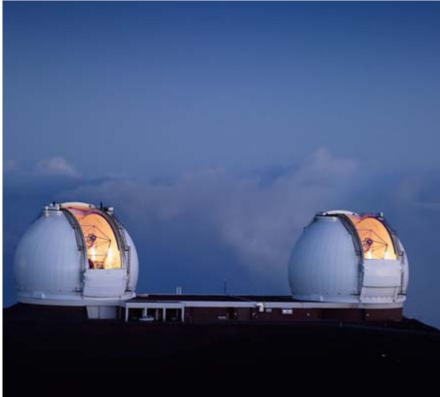
Figura 13.- Vista aérea de los telescopios gemelos Keck I y II, ubicados en la cima de un volcán inactivo en Manua Kea, Hawaii. Los espejos primarios de ambos telescopios, de 10 metros de diámetro, son segmentarios.
