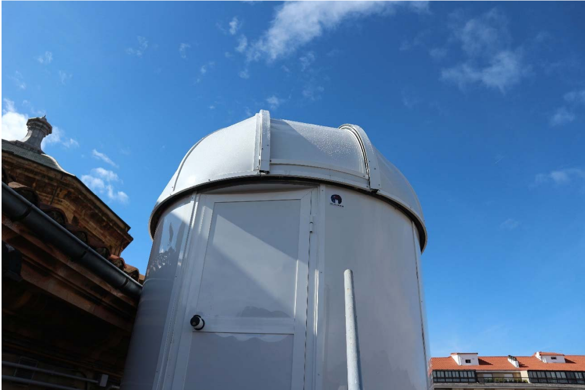
Figura 38.- Cúpula del telescopio situada en la azotea de EIMEN
