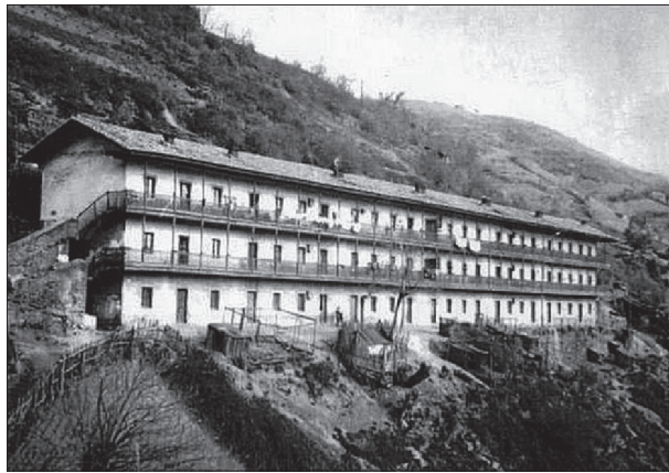
FIG. 5: La Cota, barriada minera en Boo, Aller, c. 1910. Fuente: < http://www.archivohistoricominero.org/portfolio-category/barriadas-mineras/ >.
