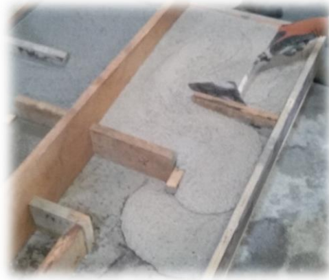
Ilustración 3.4: hormigón refractario vertido
