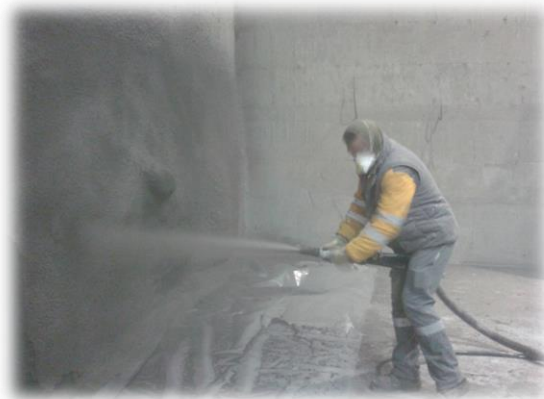
Ilustración 3.2: hormigón refractario gunitable
