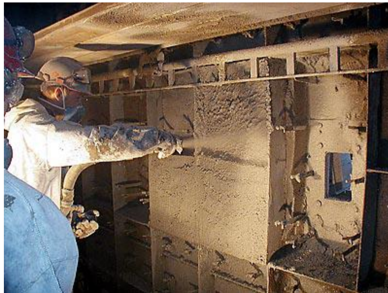
Ilustración 3.3: proceso de gunitado
