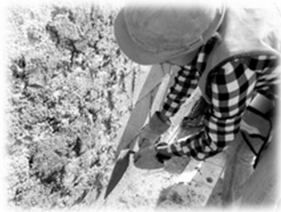
Ilustración 3.5: hormigón refractario de aplicación manual
