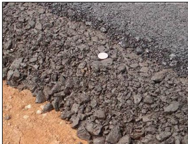
Figura 23: Aplicación de dos capas diferentes de mezclas asfálticas
