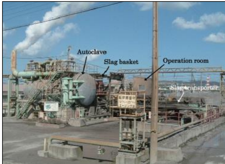
Figura 18: Instalaciones de envejecimiento a presión de Nippon Steel y Sumitomo Metal 23
