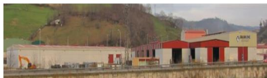
Planta de Pintura y Galvanizado, Sotrongio
