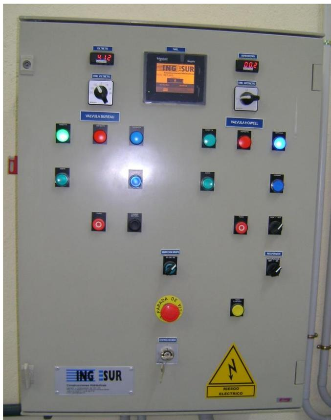
Figura 4.2- Botones, displays, selectores y seta de emergencia en la puerta del armario eléctrico.
