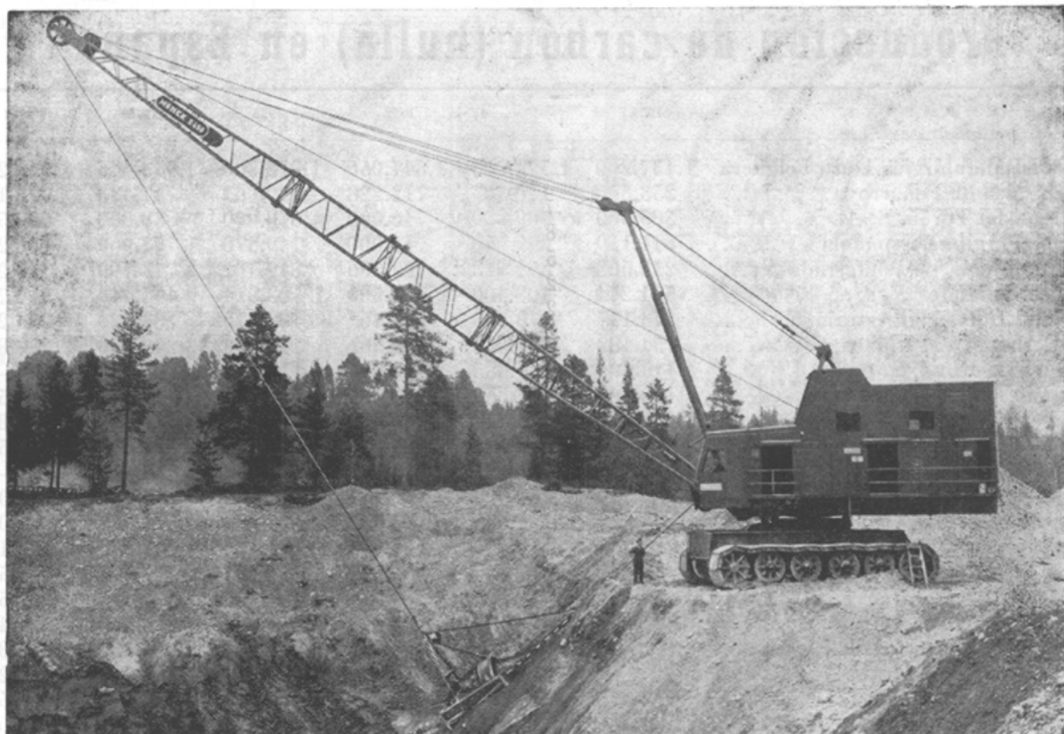
La excavadora MENCK, modelo E 450, excavando lechos de ríos en roca.
