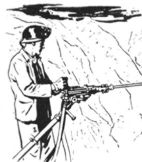
▶ **Soporte muy liviano,** de fácil transporte y montaje, adecuado para perforación en lugares poco accesibles.
