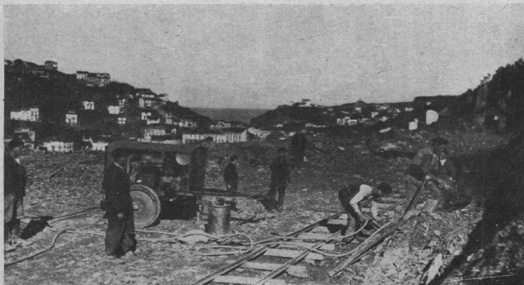
Explanación para emplazamiento de la estación de Luarca. Al fondo, el mar.
