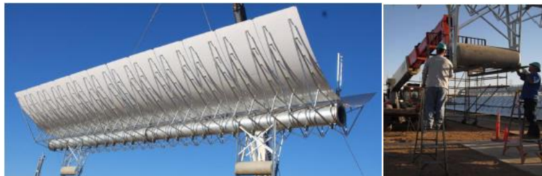
Ilustración 10 Contrapesos en tubo de torsión
