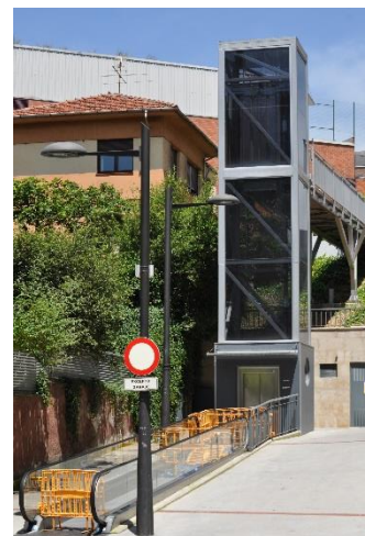
Fig. 26. Rampa mecánica y ascensor en Ciudad Naranco. Fuente: Imagen propia.
