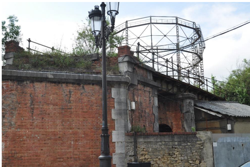
Fig.4. Restos del único puente de hierro que se conserva (El Postigo) junto a la Fábrica de Gas. Fuente: Imagen propia.
