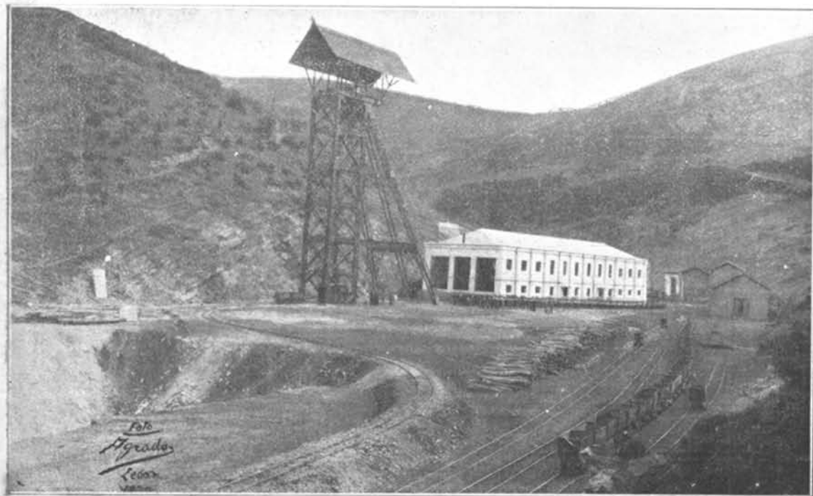
Hullera Vasco-Leonesa (Instalación exterior del pozo de Ciñera)
