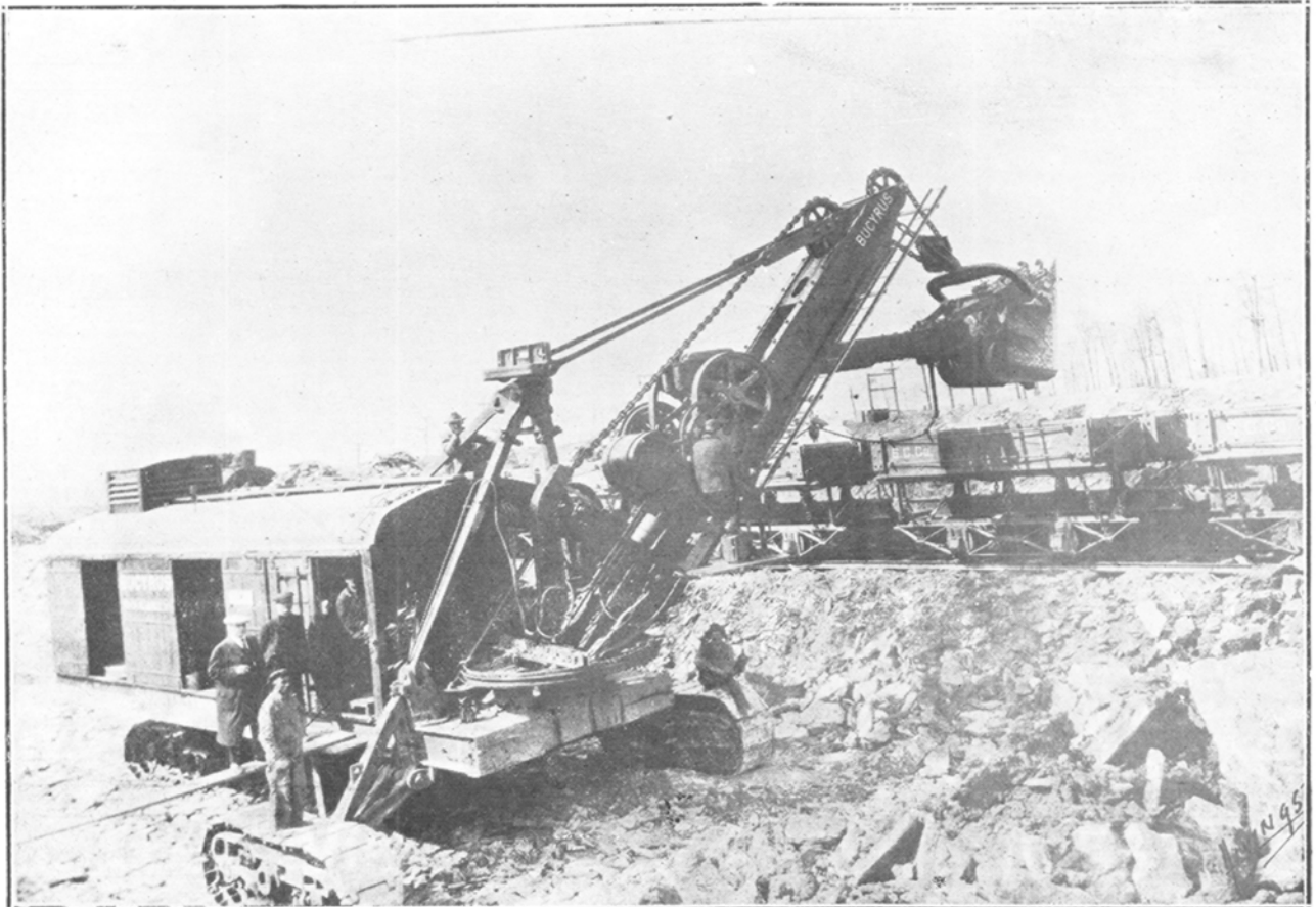
Fig. 1.—Excavadora «tipo ferrocarril» montada sobre orugas (Bucyrus)
