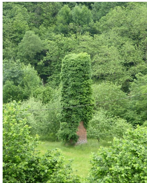
Fig.8: Chimenea de ventilación, 1900
