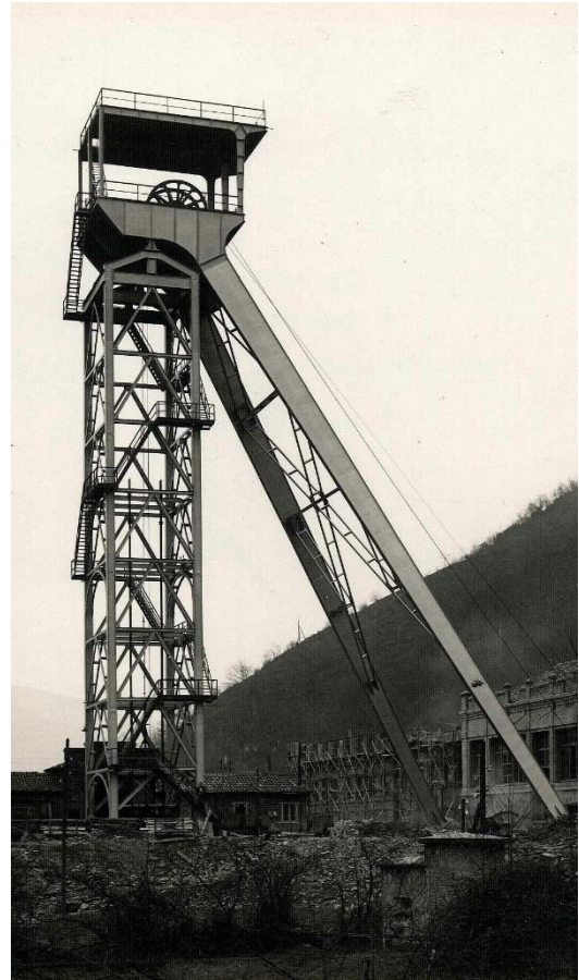
Fig.14: Castillete del pozo María Luisa construido a soldadura a principios de la década de 1940 Fuente: Archivo Duro Felguera.
