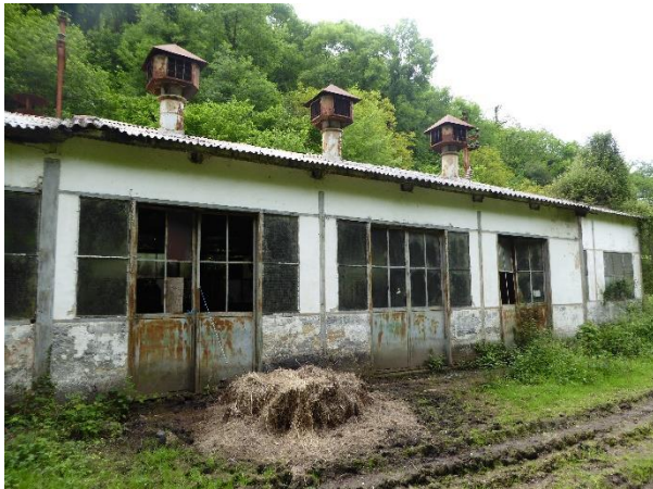
Fig.11: Sala de compresores y lampistería.
