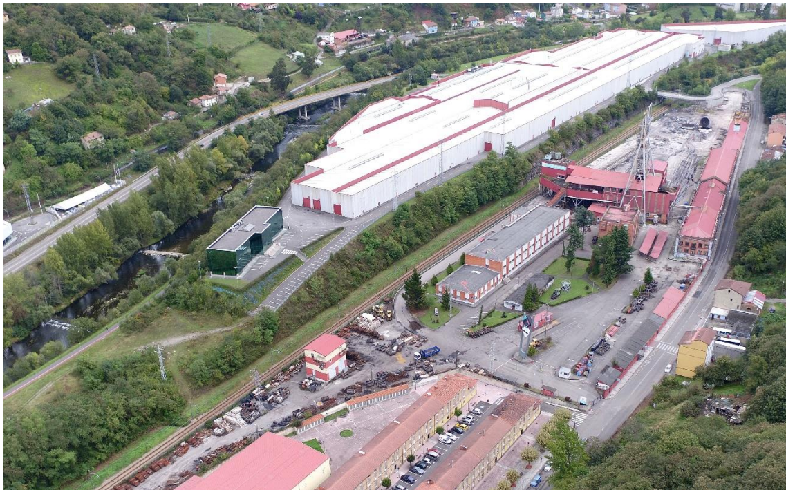
Fig. 25: Imagen conjunta del Pozo María Luisa y la Aluminera. También se observa la barriada de la Fábrica, viviendas de El Polvorín y el polideportivo de Ciaño. Fuente: HUNOSA
