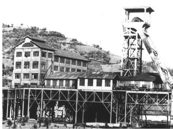
Fig. 22: Lavadero del Pozo María Luisa construido por Duro Felguera. Fuente: Archivo Duro-Felguera.
