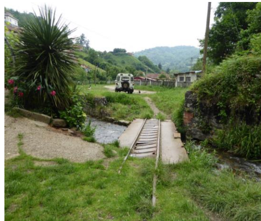
Vestigios del trazado ferroviario por el que discurrían los vagones de carbón en la Barraca, Ciaño. 2018
