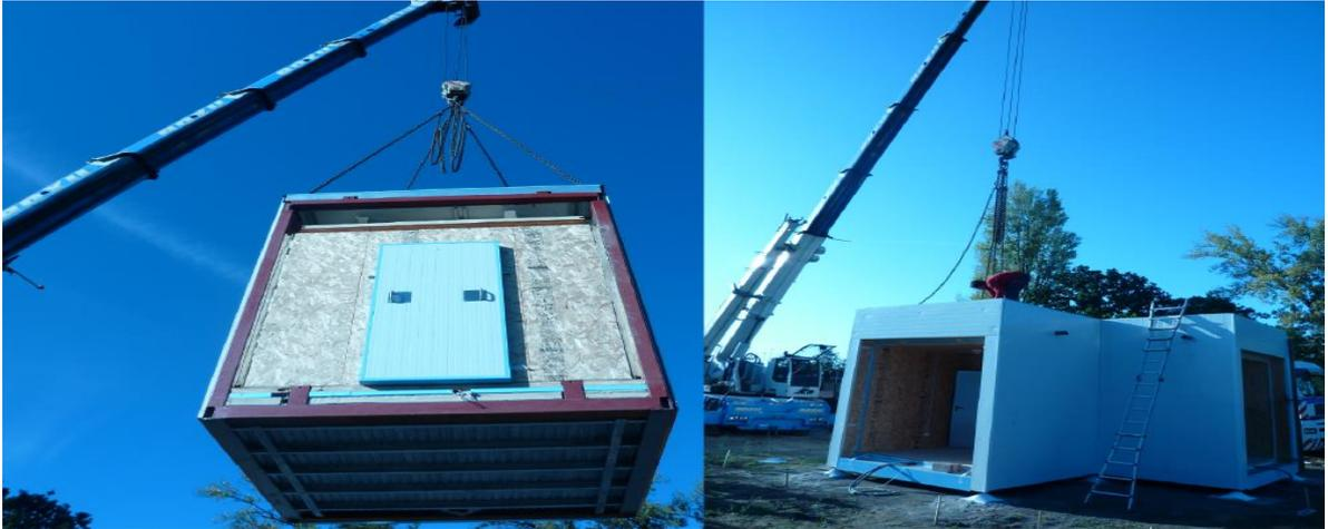
**Figura 1. Demostrador “Green Cross Lab” en base a módulos industrializados.**
