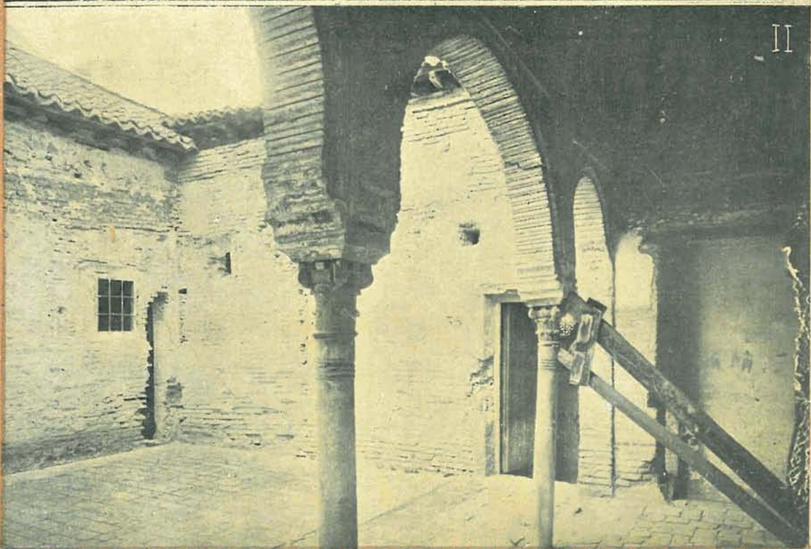
I.—PATIO DEL YESO DEL ALCAZAR DE SEVILLA AL DESCUBRIRSE II.—PATIO DEL HAREN DE LA ALHAMBRA
