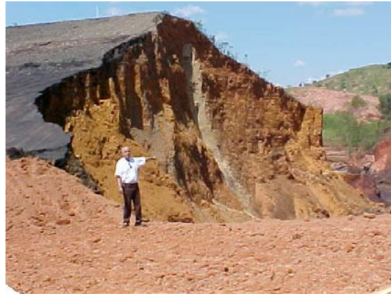
Figura 35: Rotura de una presa de relaves de Cataguases (Brasil)
