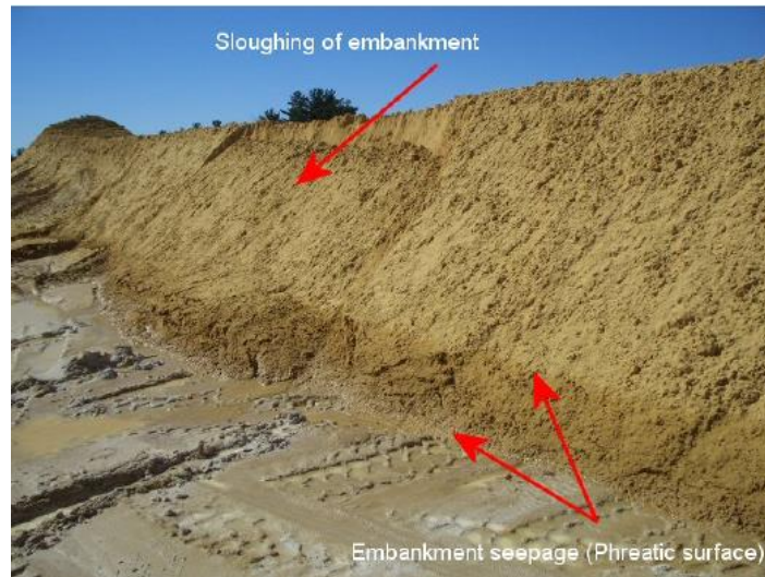
Figura 65: Desprendimiento de un terraplén de relaves causado por una superficie con alto nivel freático (Engels, 2004)
