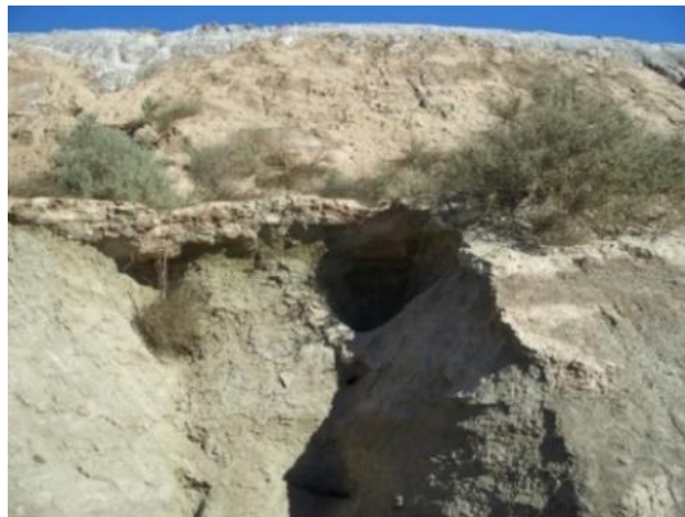
Figura 64: Fallo en una tubería y posterior erosión en una cara aguas abajo (Engels, 2004)
