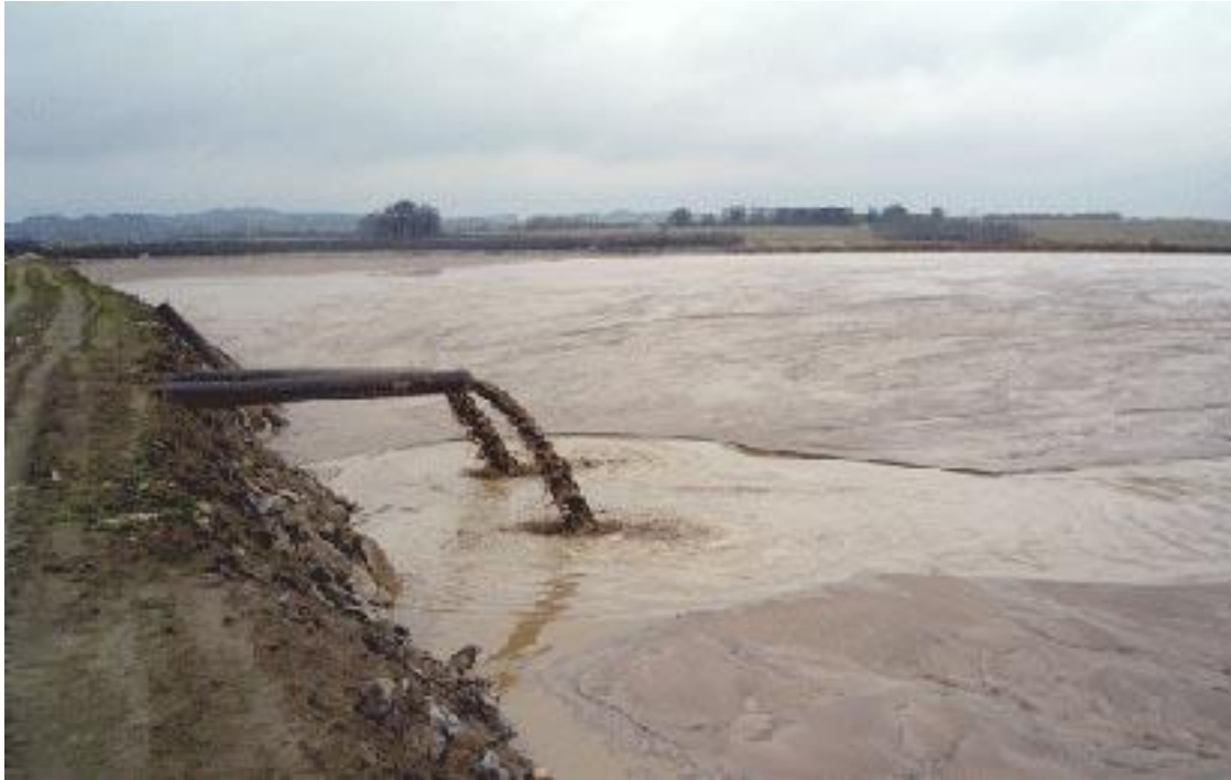
Figura 12: Punto único de descarga en la mina de Glebe, Inglaterra (Fuente: Jon Engels)
