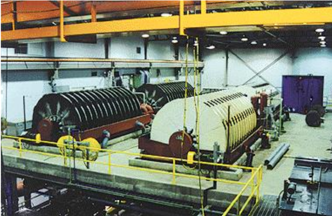
Figura 30: Ejemplo de una planta de filtrado
