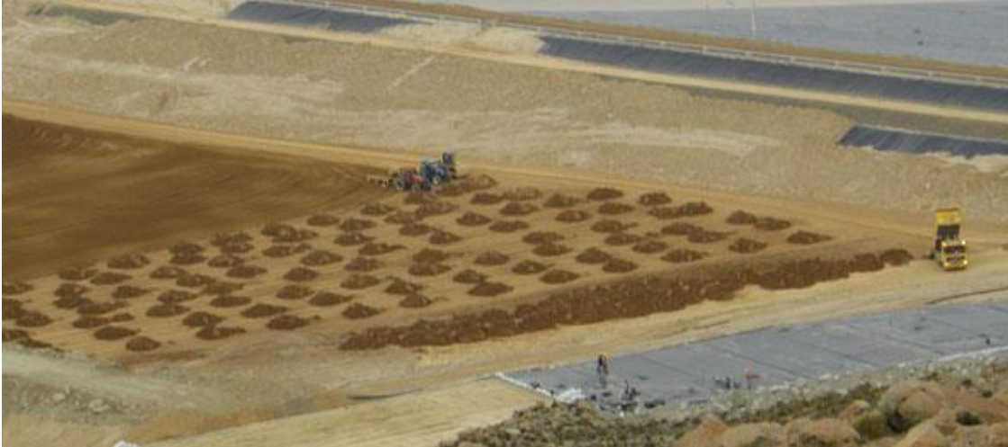
Figura 16: Apilamiento de relaves en seco utilizando transporte mediante camión (Fuente: Jon Engels)
