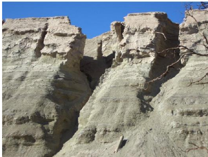
Figura 65: Desprendimiento de un terraplén de relaves causado por una superficie con alto nivel freático (Engels, 2004)
