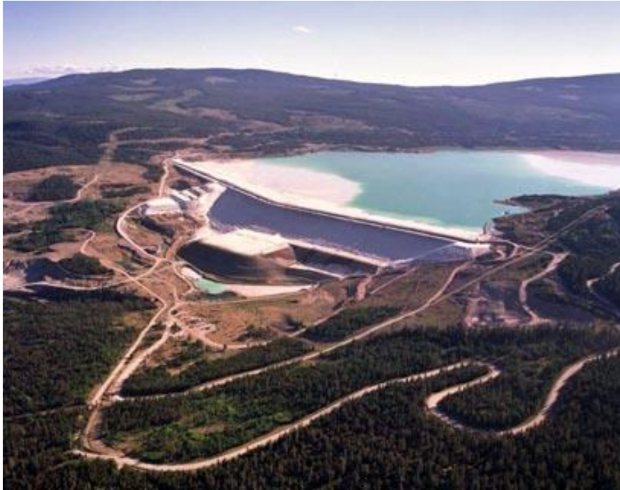
Figura 3: Vertedero de relaves de Cross Valley en Highland Valley Copper, BC, Canadá (Cortesía de Teck)
