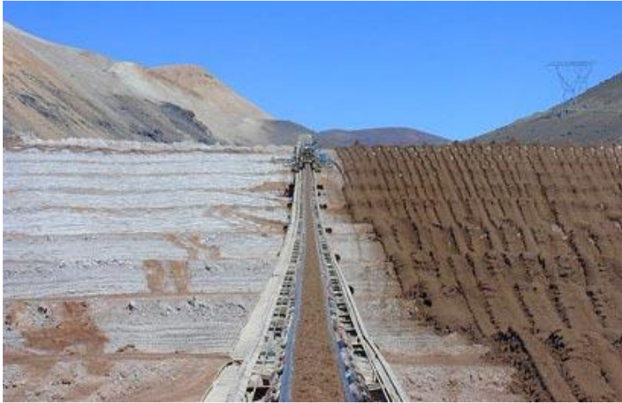
Figura 15: Apilamiento en seco de relaves mediante cinta transportadora en La Coipa, Chile
