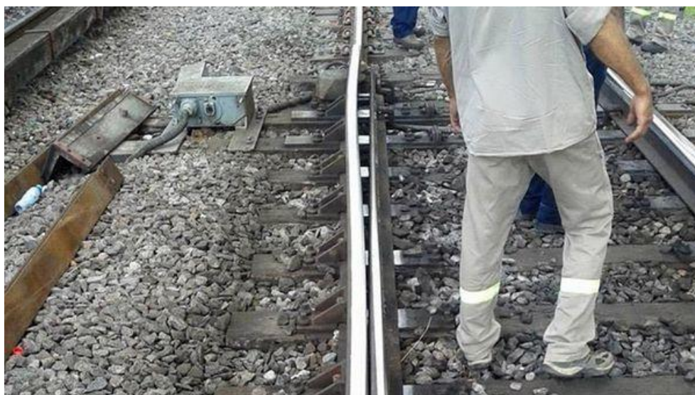
Fig. 2.2. Dilatación de las vías del tren por alta temperatura.
