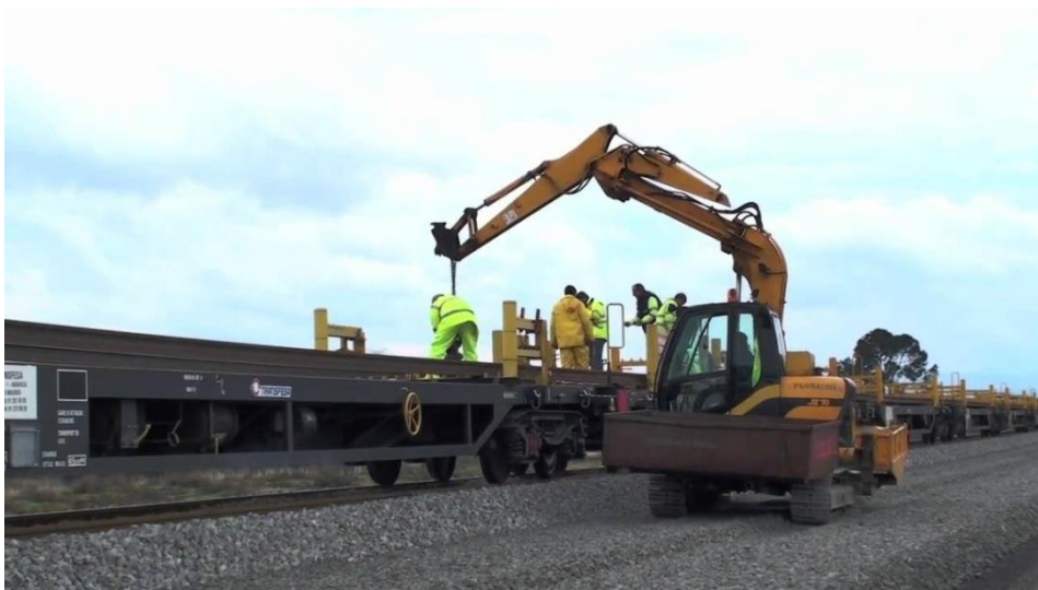
Fig. 1.9. Reemplazo de carriles.
