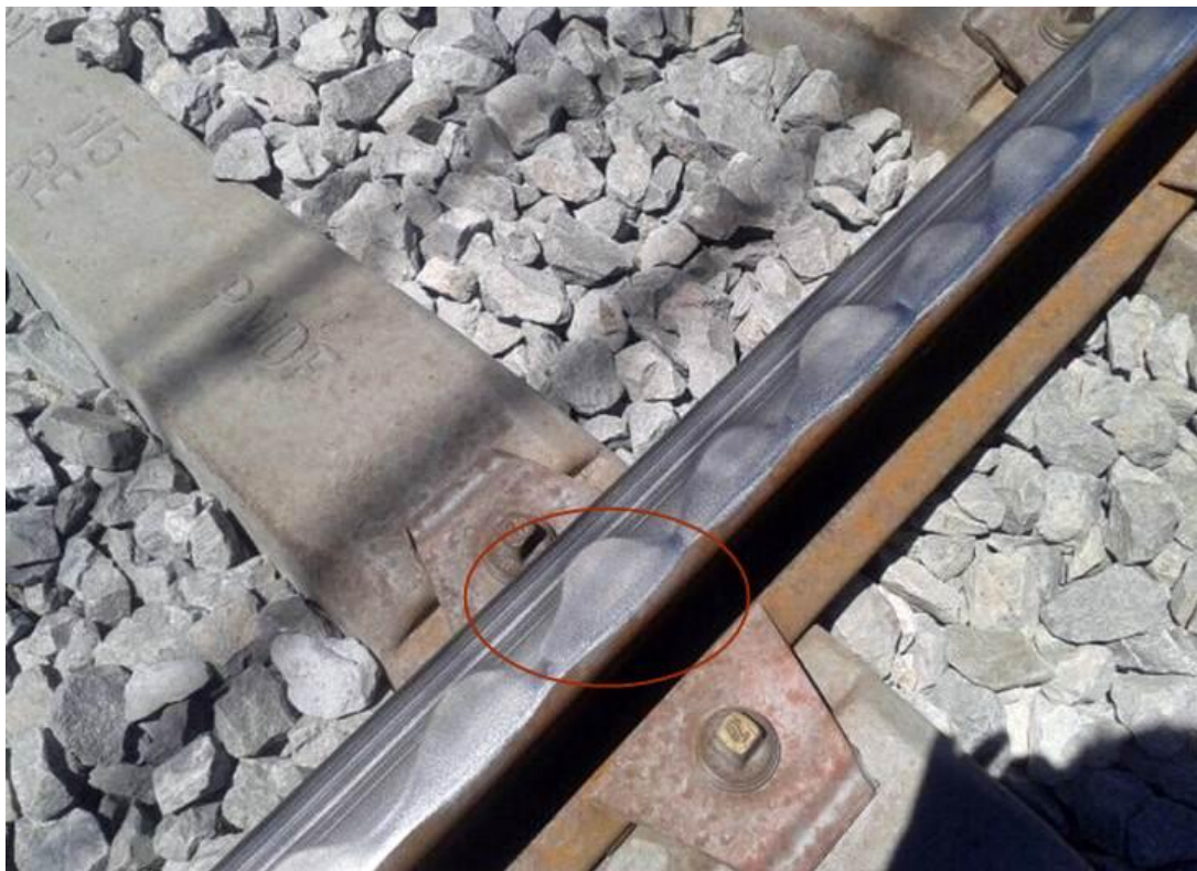
Fig. 2.17. Desgaste ondulatorio sobre los carriles.
