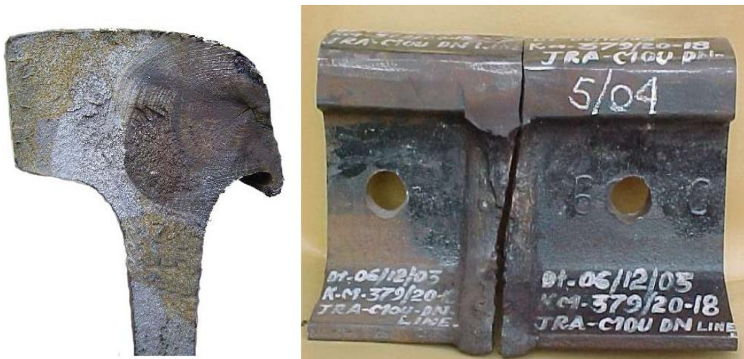
Fig. 2.4. Roturas de carriles provocadas por grietas transversales.
