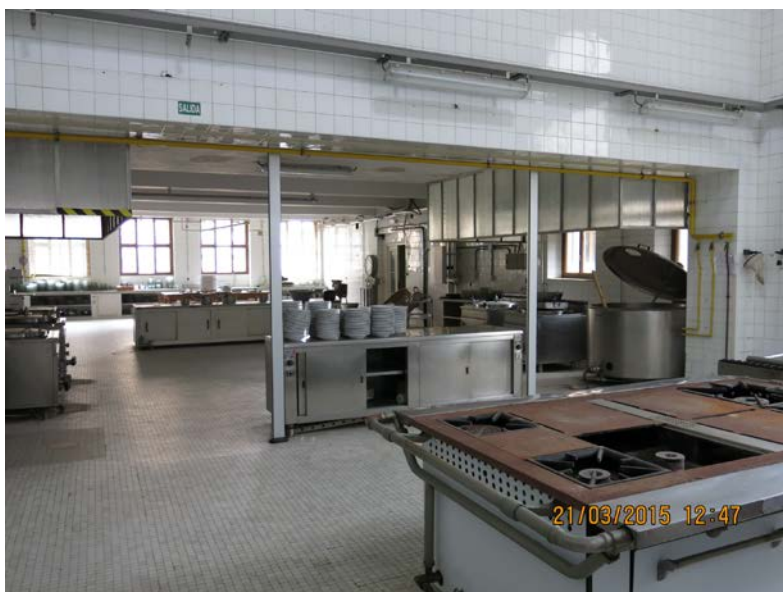
Panorámica de una parte de la gran cocina central de la Universidad Laboral de Gijón.
