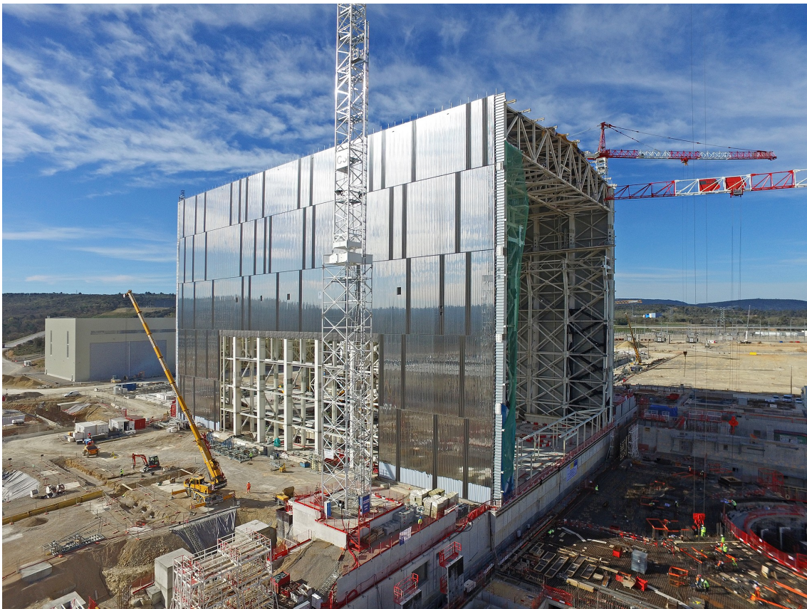
Figura 2.3: Fotografía de ITER, Cadarache, estado de su construcción en Noviembre de 2016.
