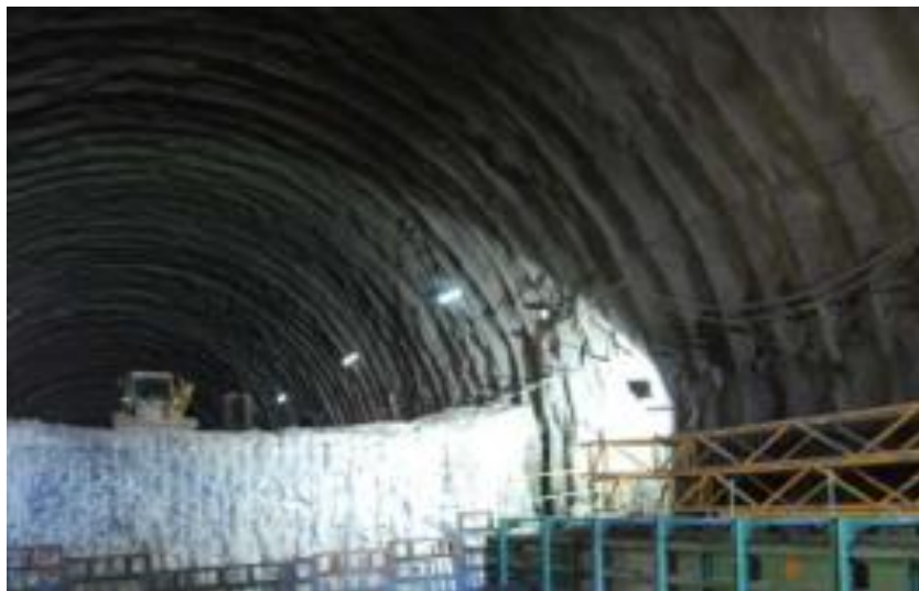
Figura 3.13. Avance de la contrabóveda muy próxima al frente de la destroza. Tomado de Rodríguez (2011).
