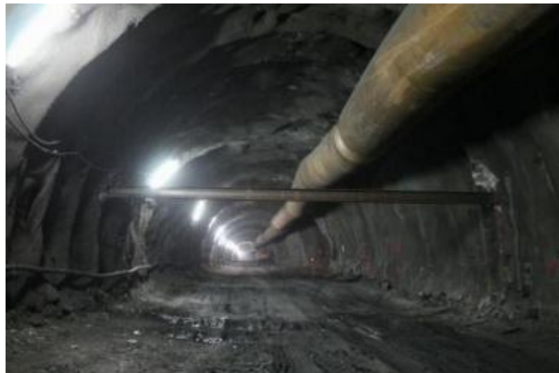
Figura 3.31. Fotografía de la colocación de malla de bulones (a) y fotografía de la solera de hormigón armado (b). Tomado de Peña y Rodenas (2011).
