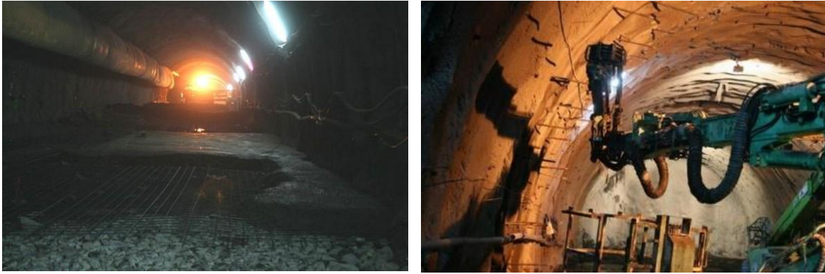
Figura 3.30. Instalación de malla de bulones (a) y proceso de ejecución de la solera de hormigón armado (b). Tomado de Peña y Rodenas (2011).
