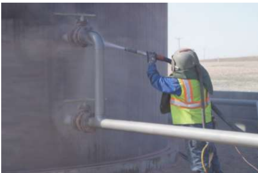
Figura 47. Limpieza por chorro abrasivo en un tanque de almacenamiento de aceite [78]
