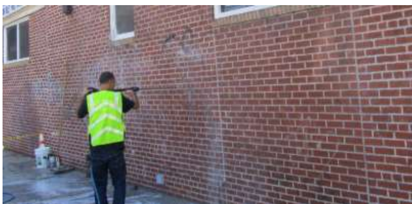
Figura 49. Aplicación de técnicas de chorreado superficial para eliminación de graffiti
