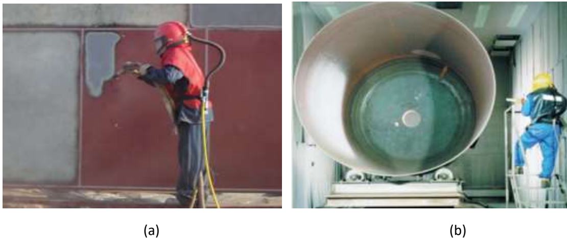
Figura 12. Métodos de aplicación de abrasivos: (a) en exterior [45]; (b) en túnel de chorreado [29]
