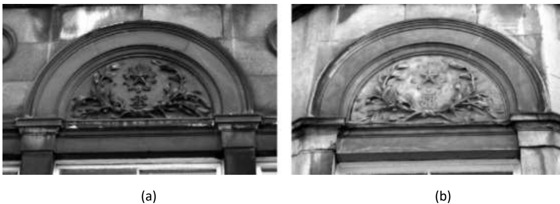
Figura 5. Detalle de dos fachadas idénticas: (a) estado natural; (b) limpiada mediante granallado [18]
