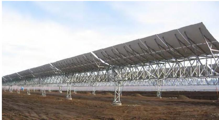
Figura 4.9. Estructura soporte de colector cilindro parabólico [8]
