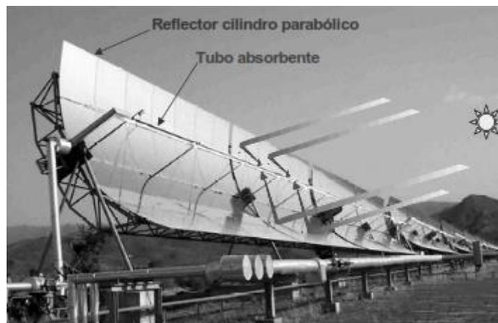
Figura 4.6. Reflector cilindro parabólico [8]
