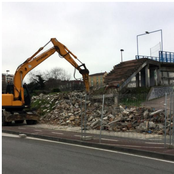
Demolición de puente para la reconstrucción (a pocos metros del instituto)
