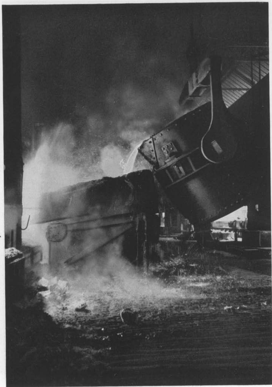
Horno de acero SM durante la carga con hierro fundido
