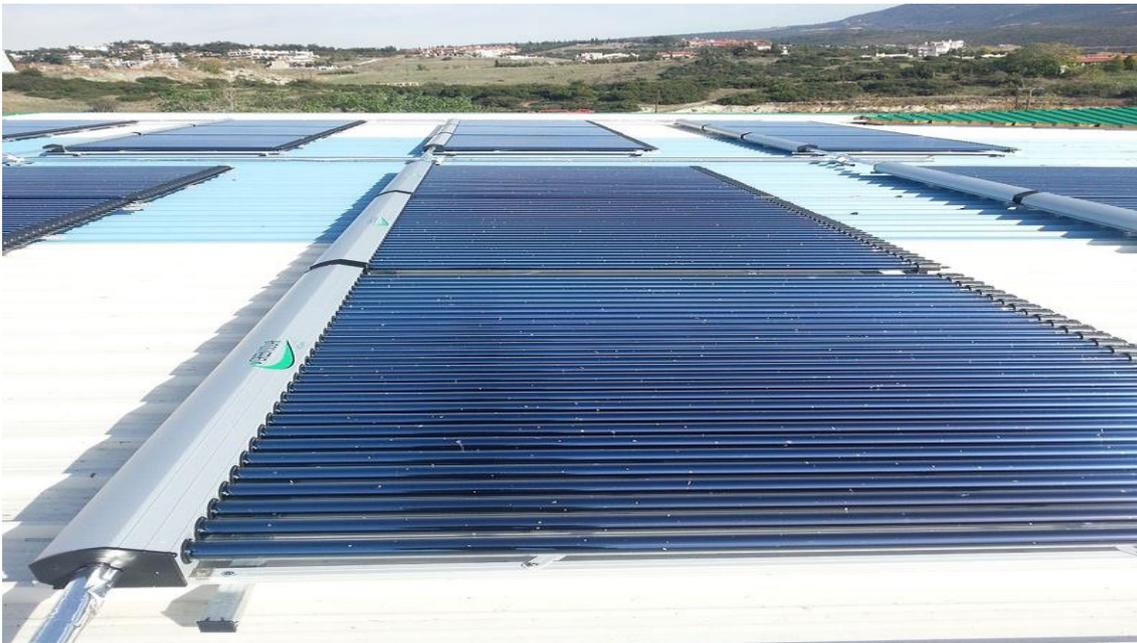
*Figura 18: Paneles solares de tubos de vacío instalados en el tejado de un edificio. Fuente: [13]*
