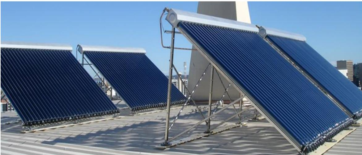
*Figura 17: Captadores solares planos para producción de ACS y calefacción. Fuente: [12]*
