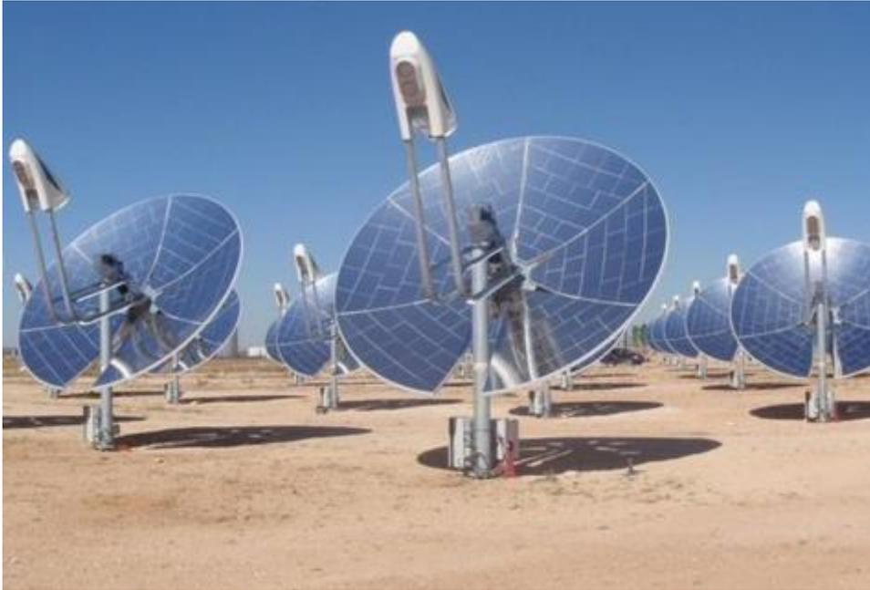
*Figura 22: Captador de discos parabólicos. Fuente: [13]*
