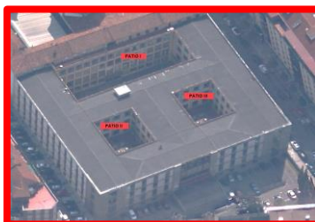
Figura 16: Muros de la Escuela de Minas (Google Maps, 2017)
