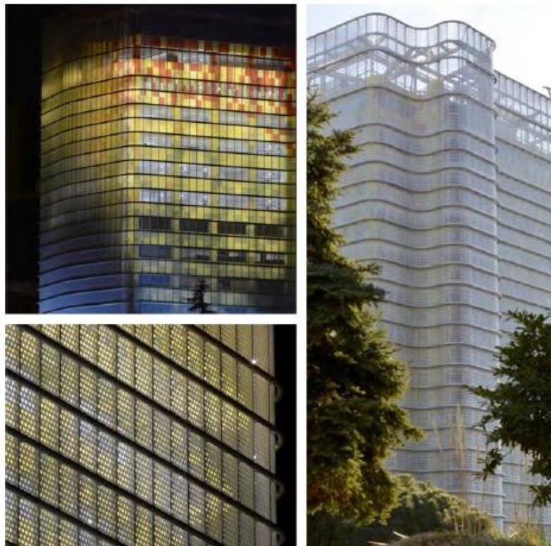
Figura 12. Ejemplo de perforaciones realizadas con troqueles.
