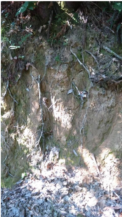
Figura 18: Foto perteneciente a la estación 9. Talud de pista, eluvión.
