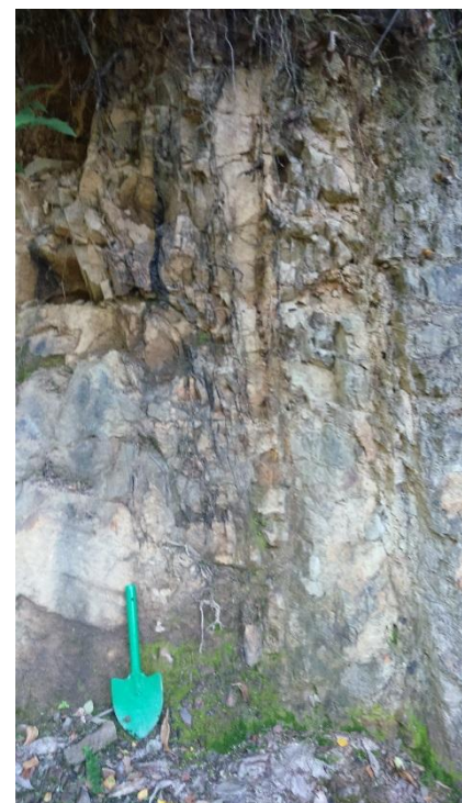
Figura 19: Foto perteneciente a la estación 10. Talud de pista, Falla.
