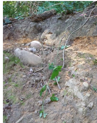
Figura 12: Foto perteneciente a la estación 4. Talud de explanación, coluvión.
