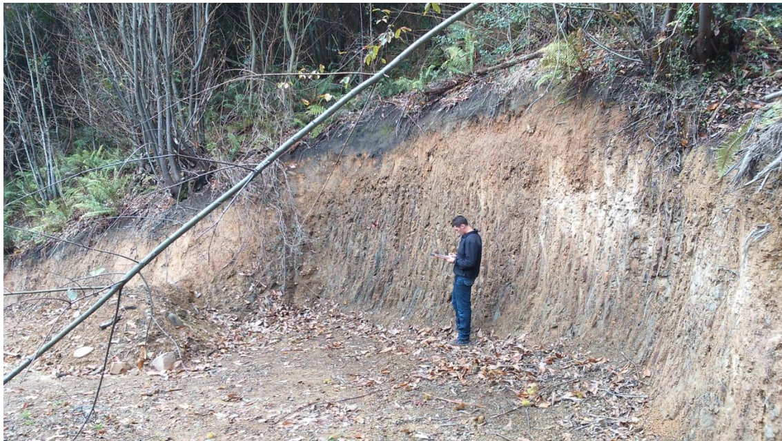
Figura 11: Foto perteneciente a la Estación de estudio 4. Talud de Explanación, zona de ubicación de infraestructuras.
