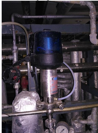
Ilustración 2.1.1-2 Válvula 2: vaciado circuito de condensados
