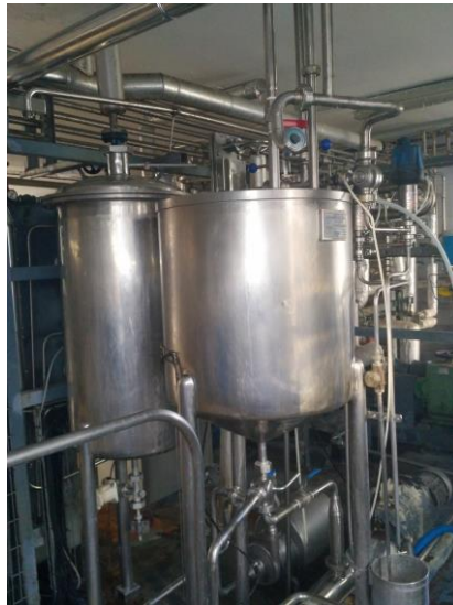
Ilustración 2.2.1-1 Tanque de alimentación
