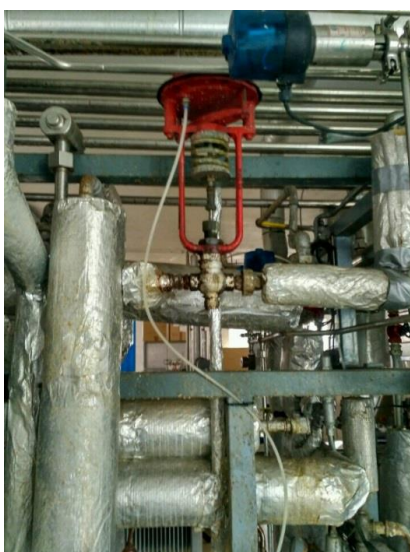
Ilustración 3.1.1-11 Válvula 12: válvula de inyección de vapor de agua caliente
