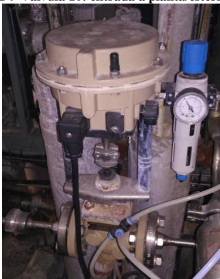
Ilustración 3.1.1-10 válvula 11: válvula de inyección de vapor
