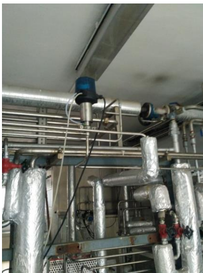
Ilustración 3.1.1-9 Válvula 10: entrada a planta/esterilización directo
