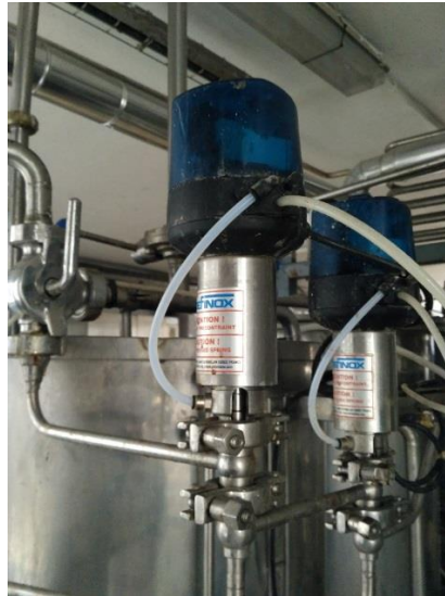
Ilustración 3.1.1-4 Válvula 4: salida producto/recirculación del producto.
