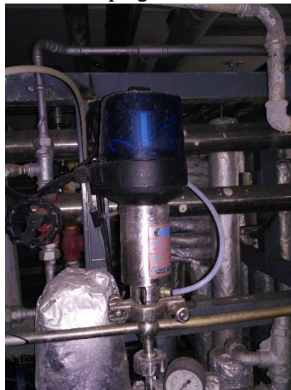
Ilustración 3.1.1-2 Válvula 2: vaciado circuito de condensados
