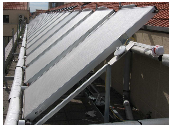
Fig. 1. Campo solar compuesto por 20 colectores situado en el edificio de Energía. Universidad de Oviedo.
