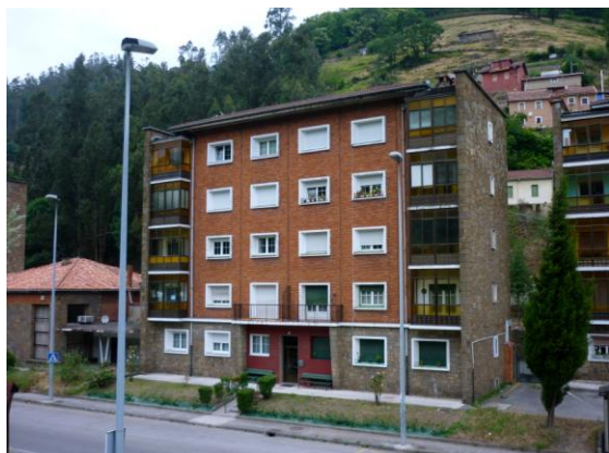
Fig. 38 Exterior de las viviendas para Minas Figaredo S.A. (estado actual); fotografías de la autora
