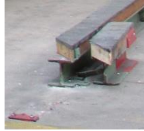
Figura 3: Fusible desplazado de su lugar
