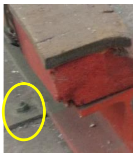
Figura 1: Pletina de acero soldada a la estructura para que se pueda atornillar al suelo
