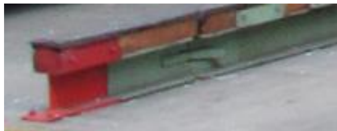
Figura 2: Fusible montando en una pata de un caballete.
