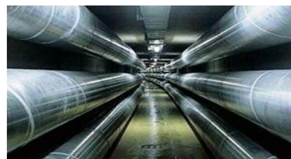
Figure 3-1 : Ligne à Isolation Gazeuse
