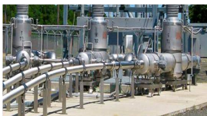
Figure 3-2 : Câble supraconducteur
