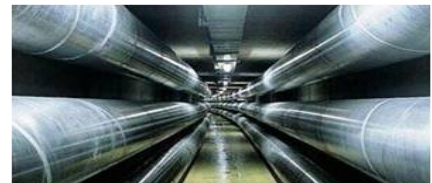
Figura 3-1: Línea de aislamiento por gas
