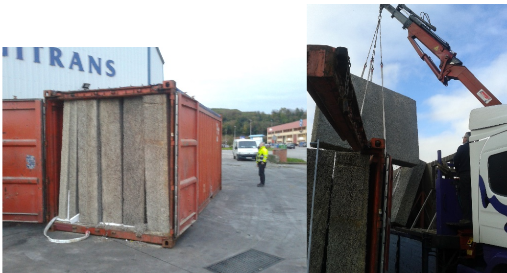
Figura 6: descarga de los paneles
