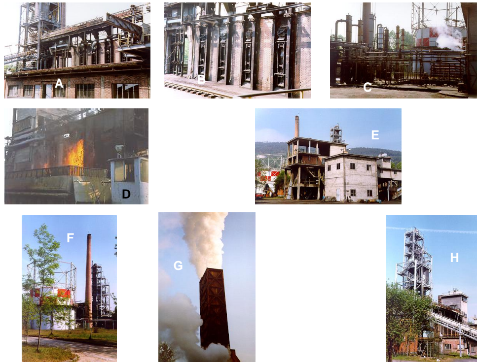
Figura 3.2.2. Distintas áreas de la planta de coquización del INCAR: A.-Batería de coquización; B.-Puertas de los hornos; C.-Planta de subproductos; D.-Deshornado del coque; E.-Estación de mezclas; F.-Gasómetro; G.-Torre de apagado; H.-Planta de precalentamiento.
