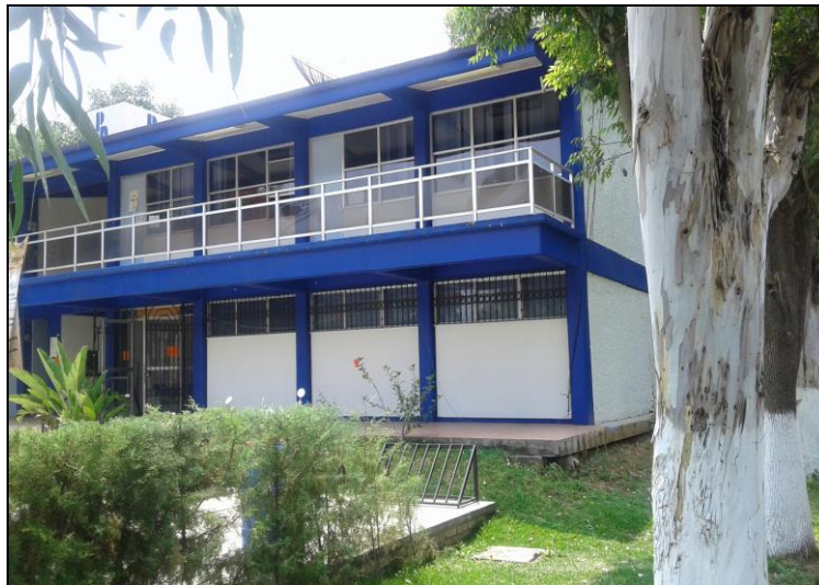
Figura n° 2. Edificio B de la UPN Zamora (Fuente: Elaboración propia).
