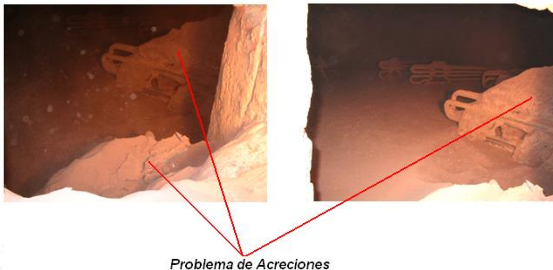
Figura 2.14. Acreciones formadas sobre haces de refrigeración en el reactor de lecho fluidizado [13] .
