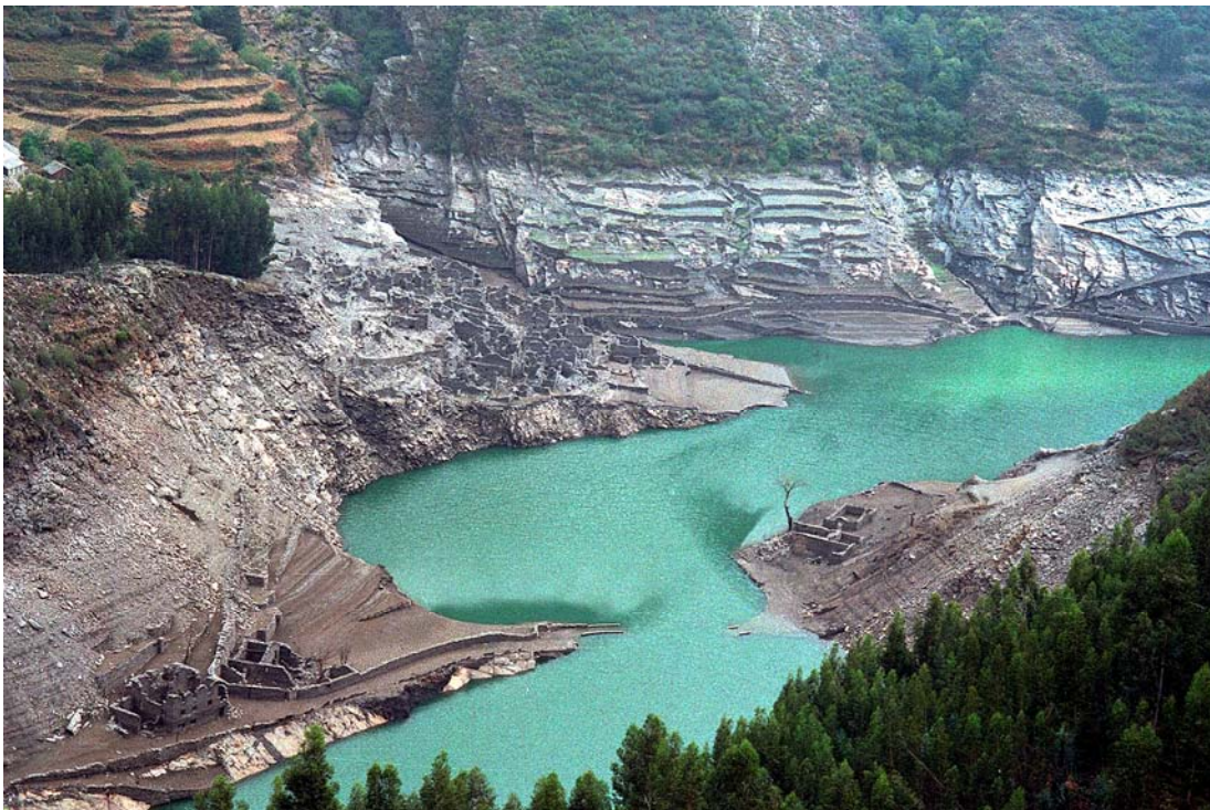
Los restos de Salime durante una reciente bajada de nivel extrema por obras.
