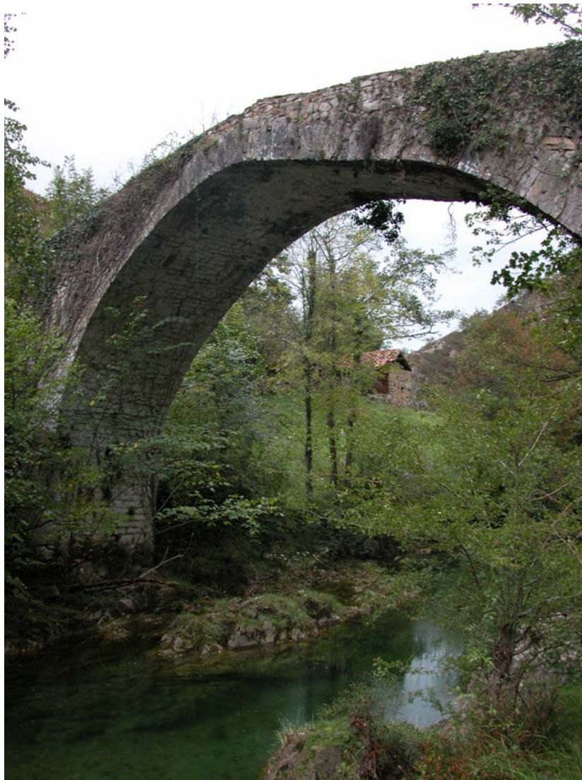
Puente Vieyu del río Dobra.
