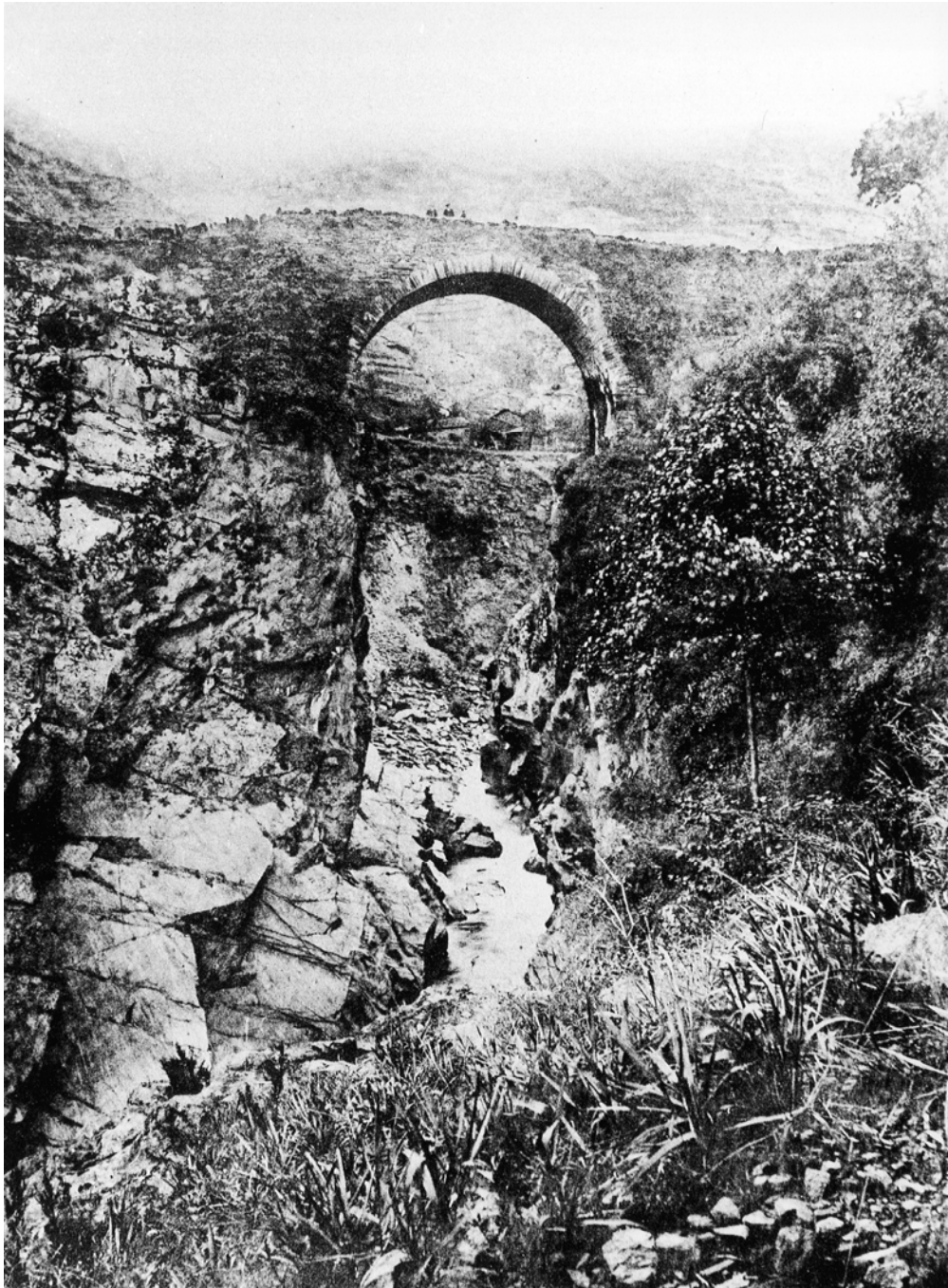
Antiguo puente de Salime sobre el río Navia.
