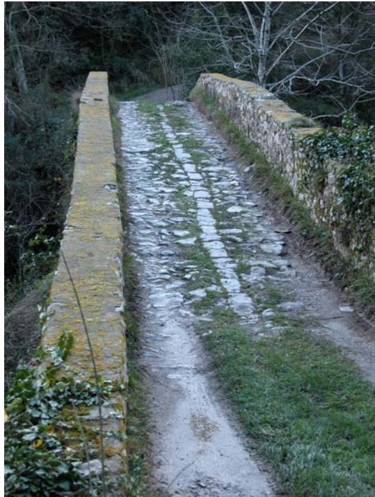
Puente de Pellamellera
