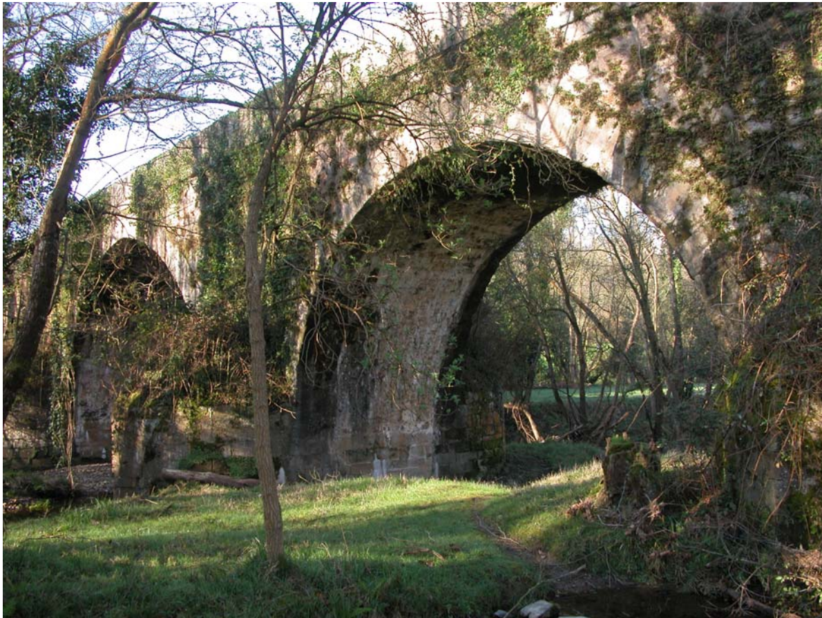
Puente de Porcía
