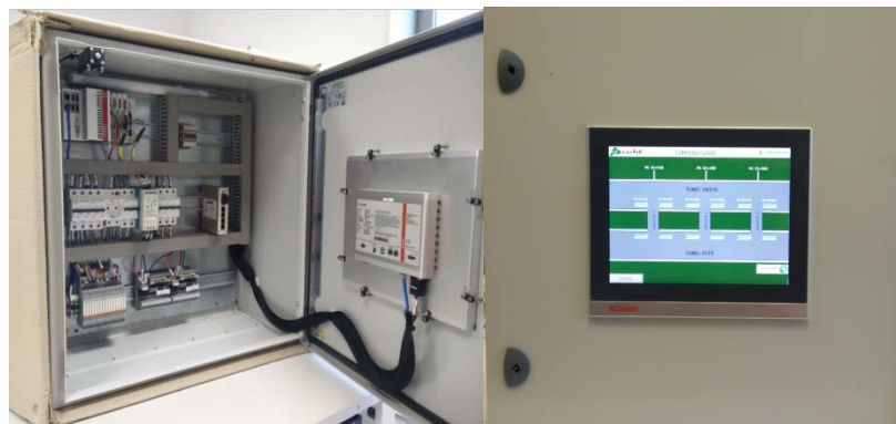
Figura 40: Ubicación pantalla táctil dentro del cuadro.
